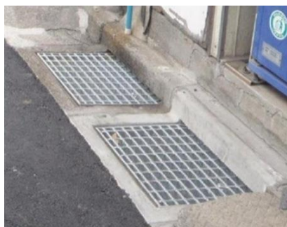
コンクリート蓋をグレーチング(Gr)へ交換
