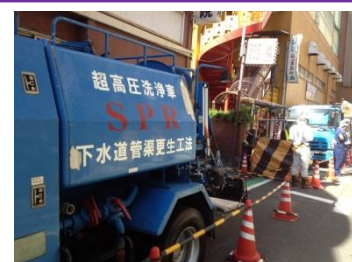
↑下水道再構築工事 古くなった下水管を再構築して耐久性・耐震性を増すほか、流下性能を確保
