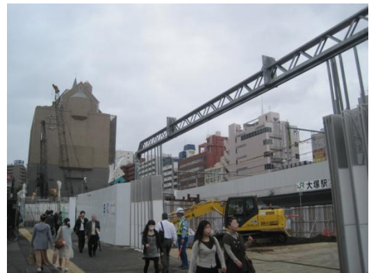
JR 大塚駅南口ビル(仮称)建設工事の様子
