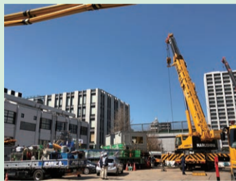
作業ヤードの上池袋東公園 現在はシールドマシン準備工事中
