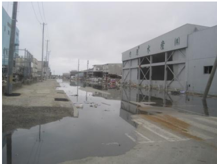
↑石巻港近く。前日の雨で道路が冠水
